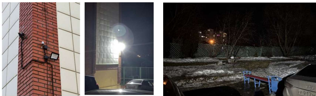
Рис. 1. Имеющиеся источники освещения на объекте
