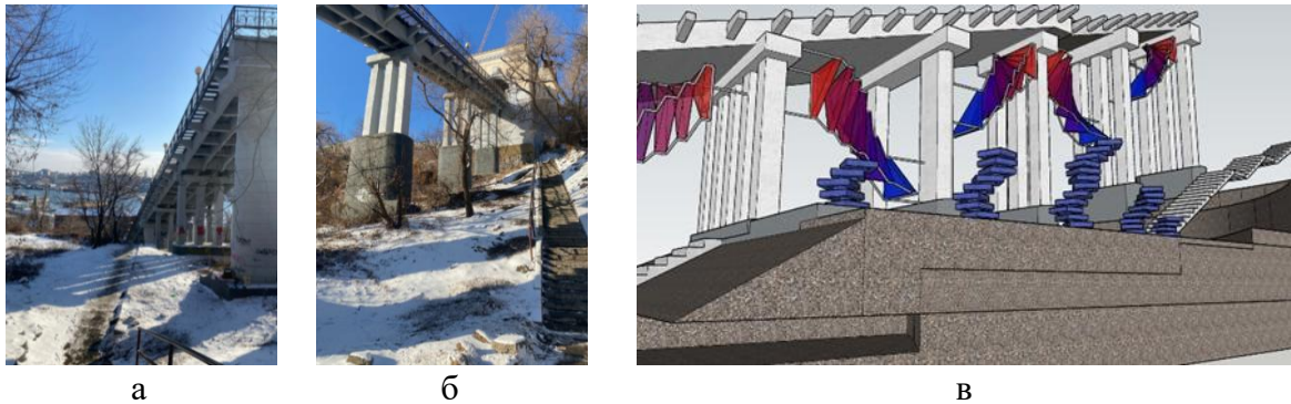
Рис. 1. Предпроектный анализ и компьютерное моделирование: а, б – фотофиксация существующей среды, лестница на рельефе и транспортные опоры фуникулера; в – компьютерная модель
