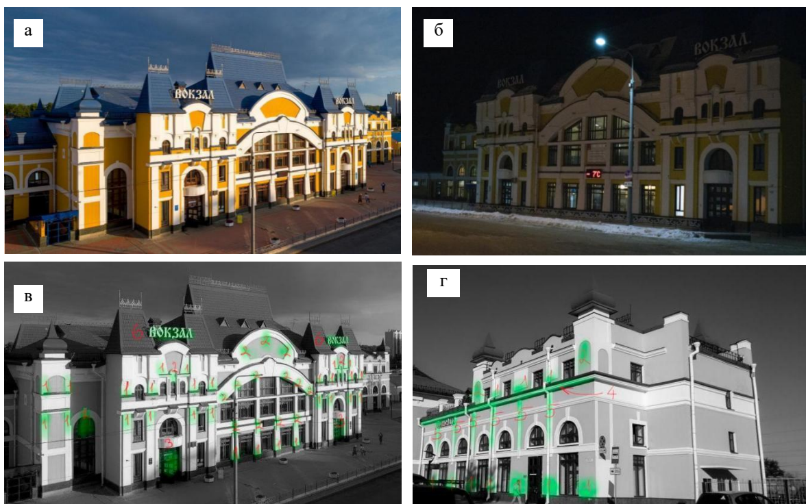
Рис. 2. Здание ж/д вокзала в дневное (а) и вечернее (б) время; компоновка данных по светопланированию и схематическому представлению расположения световых приборов на главном фасаде (в) и боковом строении – протяжённой его части (г).
